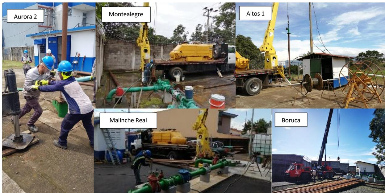
Figura 25. Registro fotográfico de cambio de equipos de bombeo y mantenimiento de pozos
